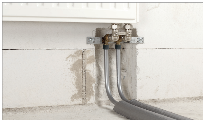
RAUTITAN fűtési előszerelt tartó beépített szelepes radiátoron
