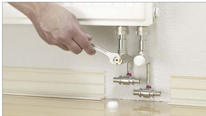
16-45. ábra A szorítógyűrűs csavarzat meghúzása
