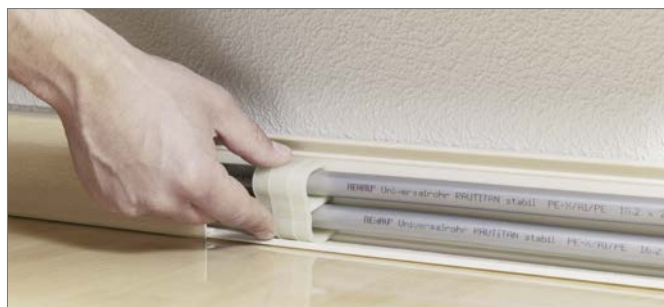
16-36. ábra A fűtőcső tartó bepattintása
