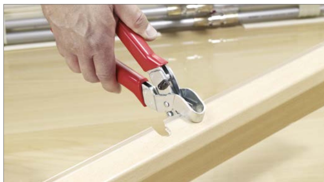
16-46. ábra A falszegély csatorna felső részének kivágása
