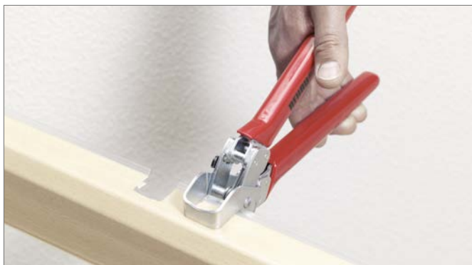
16-39. ábra A falszegély csatorna felső részének kivágása
