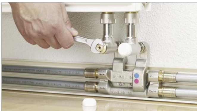
16-38. ábra A szorítógyűrűs csavarzat meghúzása
