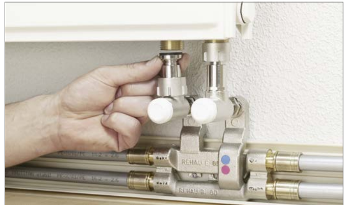
16-26. ábra A teleszkópos könyökcsavarzat egység csatlakozása
