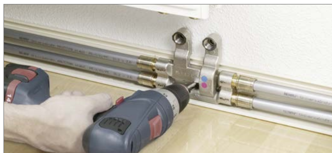
16-35. ábra A RAUTITAN SL keresztelő idom rögzítése
