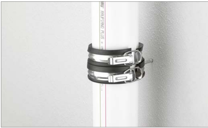
9-6. ábra Készre szerelt testhangszigetelő támasztöröggtítés
